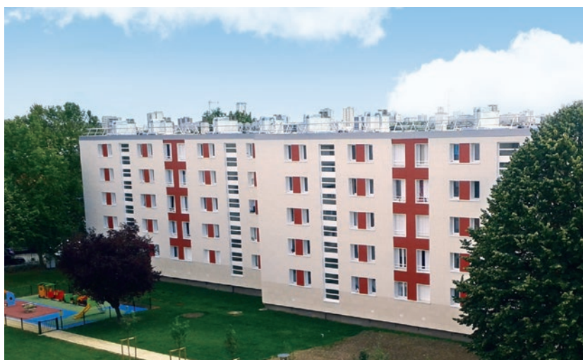
« Les 144 logements de la résidence Les Buissons à Sannois (95) ont bénéficié d'importants travaux de réhabilitation. »
